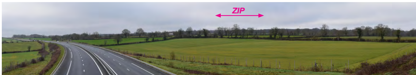
Photographie 58 : Depuis un franchissement au-dessus de la N249, au nord de l'AEI, la ZIP est bien visible ; elle reste bien plus discrète depuis la route elle-même, étant en grande partie masquée par la végétation.
